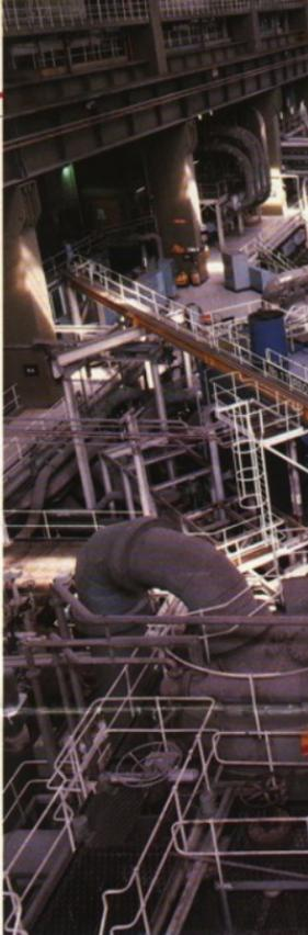
*Al hervir, el agua produce vapor que hace girar las turbinas. Después el vapor se condensa y forma de nuevo agua. La turbina hace rotar las bobinas de alambre en el fuerte campo magnético de un generador. Como las bobinas rotan en un campo magnético, la corriente que se produce en ellas se alterna, es decir, cambia su dirección de positivo a negativo, de nuevo a positivo, y así sucesivamente.*
