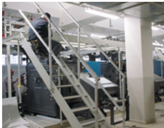
Монтаж роллонной печатной машины Mercury
